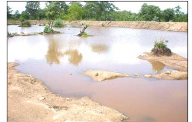
गाँवों की खाली जमीन पर तालाब निर्माण
