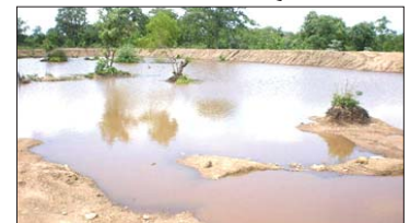
गाँवों की खाली जमीन पर तालाब निर्माण
